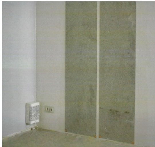
Foto 6. Laten drogen na het lijmen
