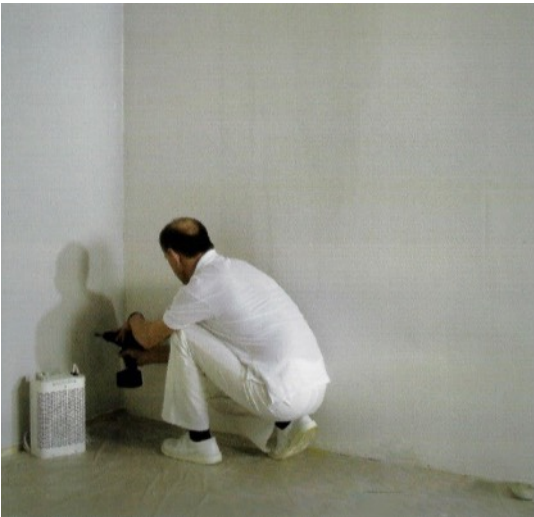
Foto 3. Plaats bepalen van de transformator
