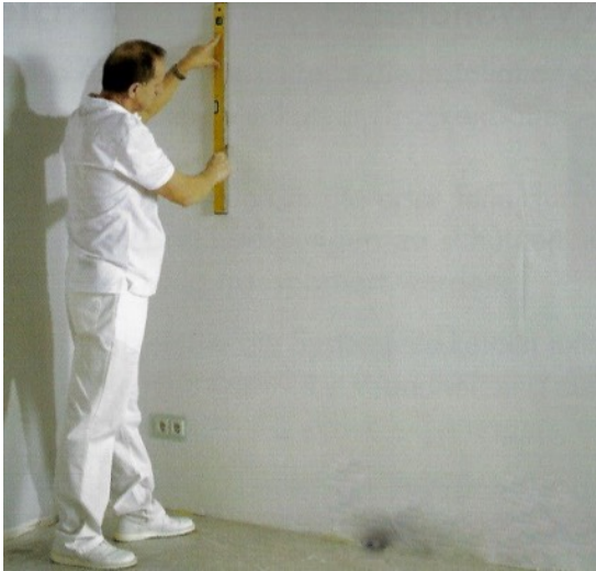
Foto 1. Het intekenen van de verwarmingsmatten
