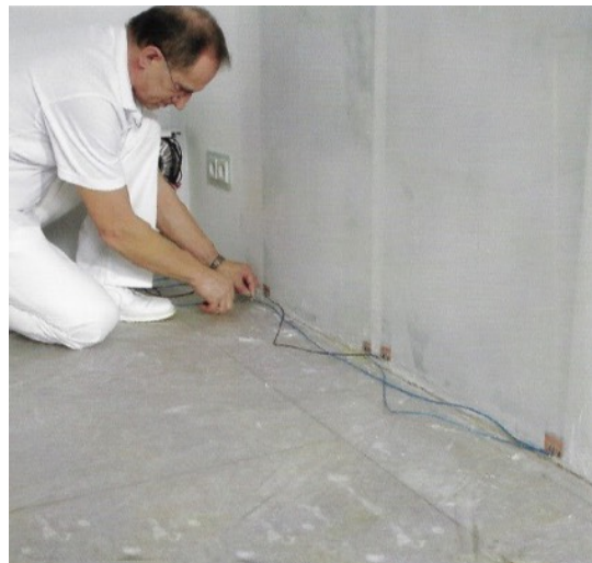
Foto 10. Leggen van de elektrische kabels
