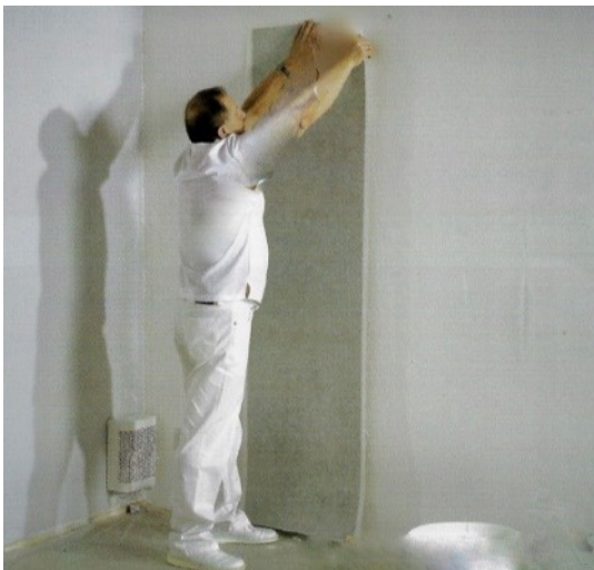
Foto 5. Verlijmen van de verwarmingsmatten
