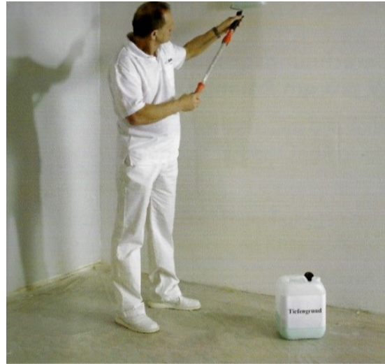
Foto 2. Impregneren van sterk zuigende ondergrond
