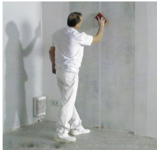
Foto 12. Pleisterwerk glad schuren en eind afwerken
