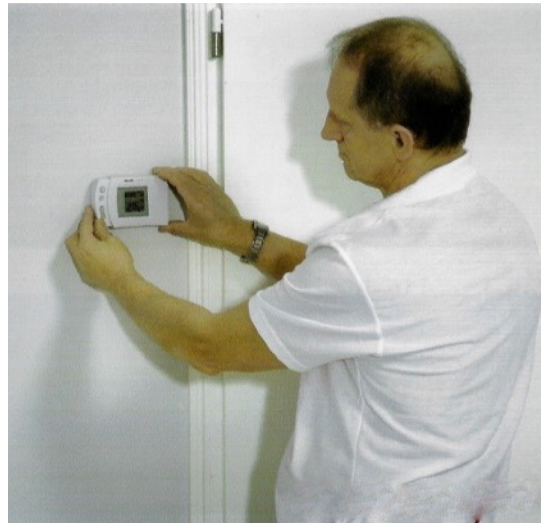
Foto 4. Plaats bepalen voor de thermostaat
